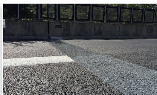
秋田自動車道 大曲 IC(上り線) 2015 年 11 月施工
