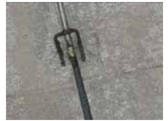
4. ロードセイバーシリコン充填工
