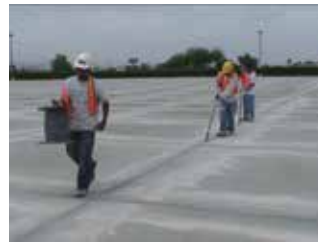
3. バックロッド設置工
