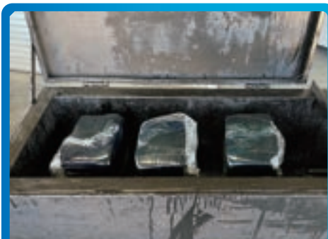
④ 溶解 マスチックワンを完全に溶解する 充填温度は 190℃～204℃
