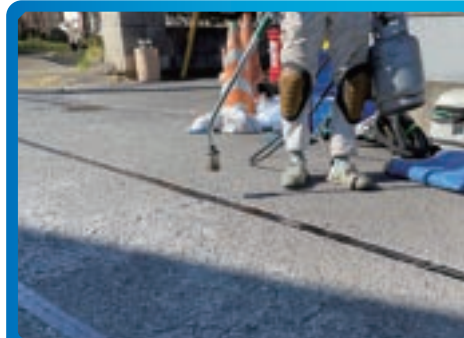
③ 端部処理工 クイックシールを端部に貼付けバーナーで炙る
