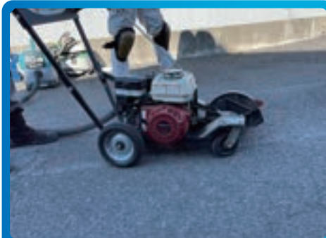
② 目地掃除工 ブリーゴートで目地部を掃除する
