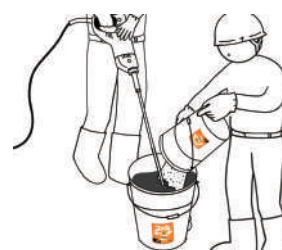
10. 先ほど混ぜた粉末のペール缶を 液体のペール缶の中にいれます
