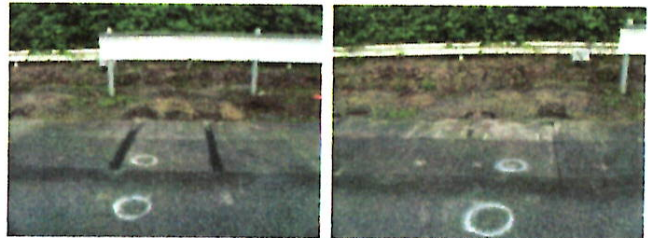
写真-14 施工状況(左:水抜き排水性舗装工区、右:カッター工区)
