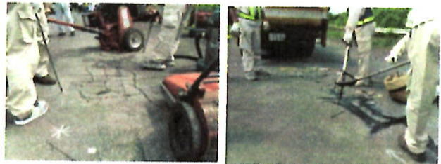
写真-7、8 クラックカットシール工法施工状況
