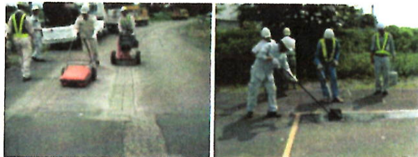
写真-9、10 E工区施工状況
