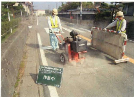
写真-2 クラックカット状況
