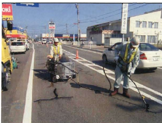
写真-1 シール材注入工施工状況
