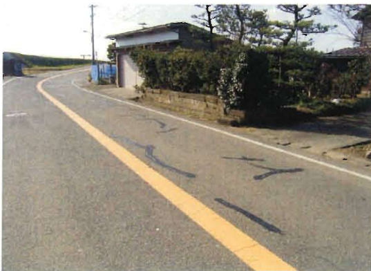
写真-9 B路線の加熱型材料施工後の状況①
