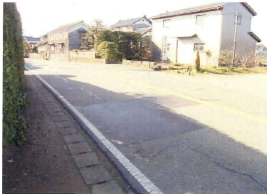
写真-14 B路線の常温型乳剤系材料施工後の状況
