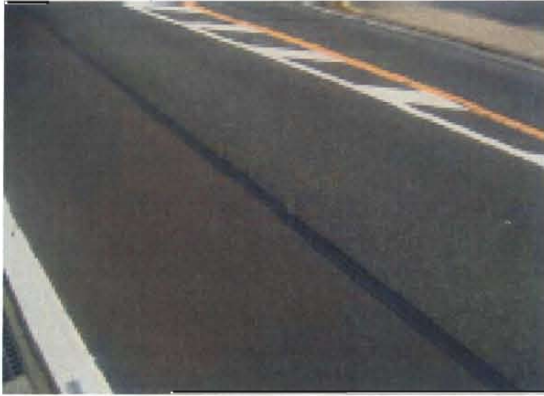
写真-13 A路線のクラックカット工法併用施工箇所の状況
