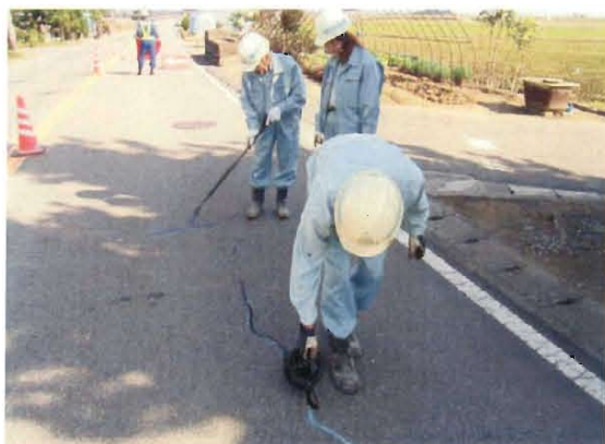
写真－4 常温型材料の施工状況
