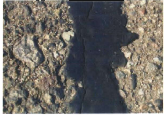
写真-16 C路線の常温型乳剤系材料施工後の状況
