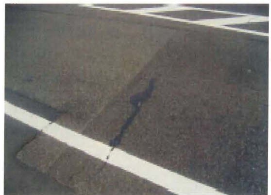
写真-11 C路線の加熱型材料施工後の状況
