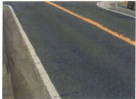
写真-17 C路線の常温型樹脂系材料施工後の状況
