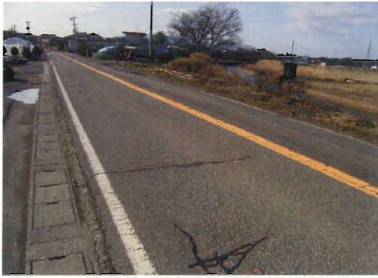
写真-7 B路線の加熱型材料施工後の状況①
