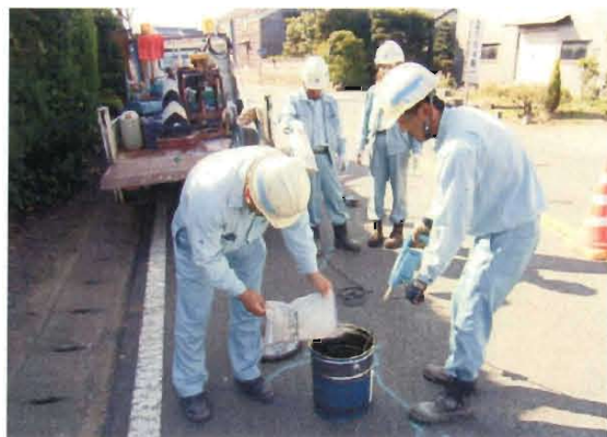
写真－3 固化材の投入状況
