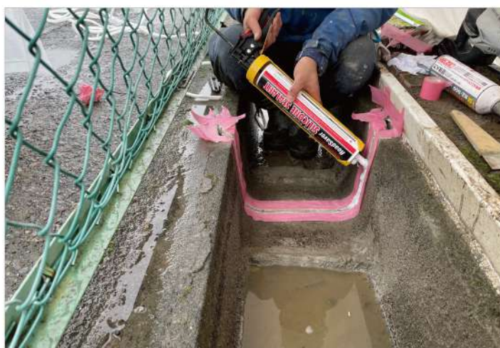
4 充填 ロードセイバーシリコンNSを充填する。
