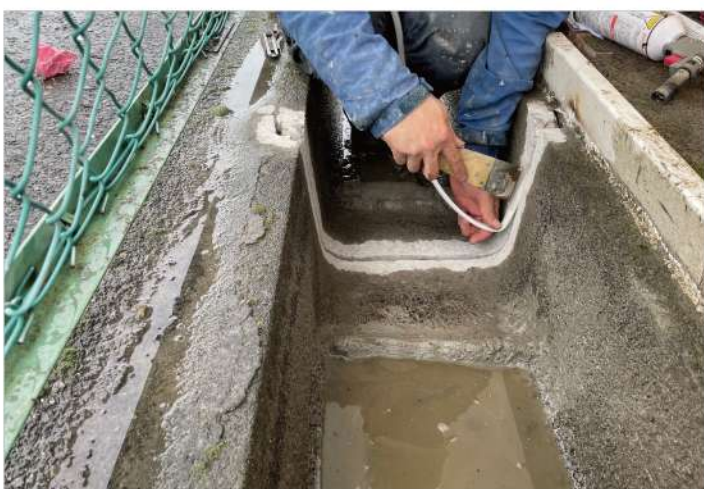
3 バックアップ材設置
