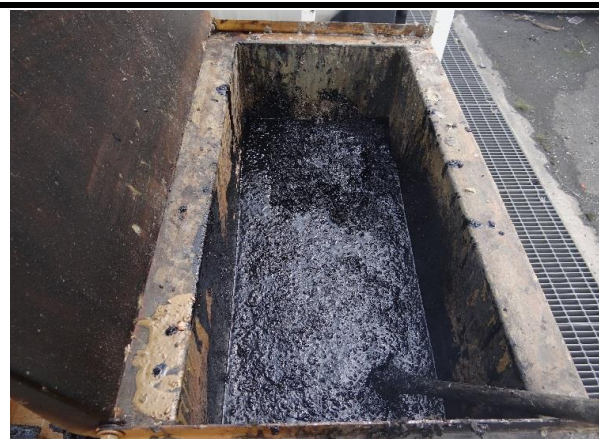
③ 材料溶解 焦がさないように混ぜることが重要です。
