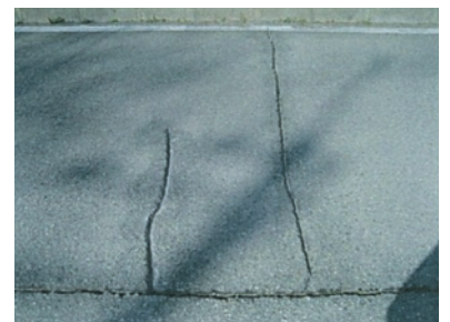
ひび割れをカットした状況
