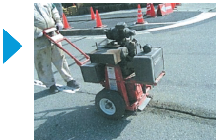
ひび割れを専用カッターで切削
