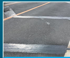
施工打ち継ぎ目クラック・段差補修
