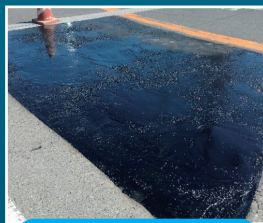
橋の入口部段差補修
