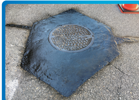
② マスチックワン敷き均し
