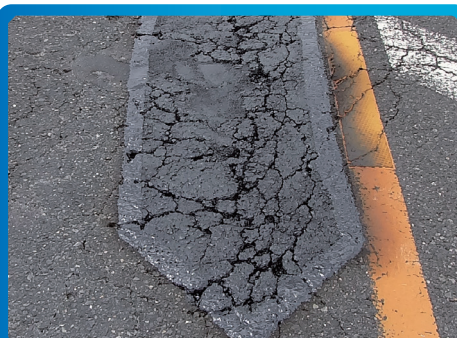
① クイックシール貼付け ② MK プライマー塗布
