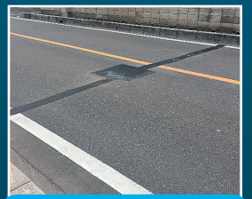
施工打ち継ぎ目クラック・段差補修
