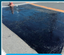
橋の入口部段差補修
