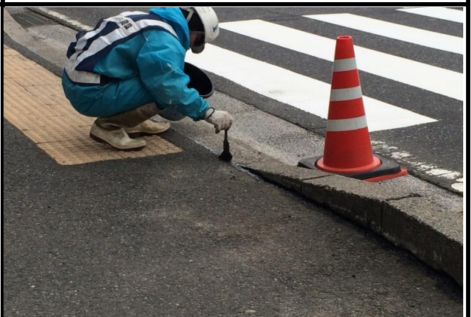
④プライマー塗布作業 プライマーを塗布する。(塗布量 0.36\text{kg}/\text{m}^2 (0.33kg) / \text{m}^2 )
