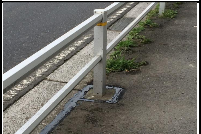
④プライマー塗布作業 プライマーを塗布する。(塗布量 0.36\text{kg}/\text{m}^2 (0.33kg) / \text{m}^2 )
