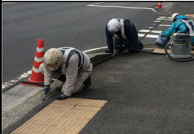
③清掃作業 バーナーなどで乾燥後、ブラシで箇所を磨き、掃除機で砂などを吸い取る。
