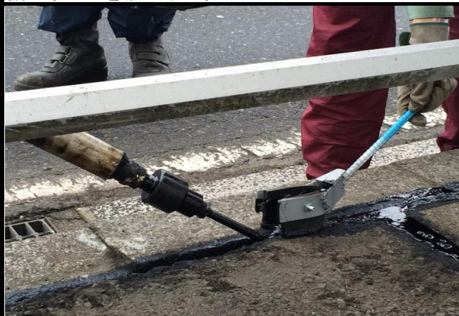
⑤シールを充填 193^{\circ}\text{C}\sim 203^{\circ}\text{C} に温めたシール材を充填い、コテで均す。
