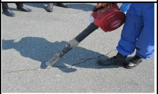
④清掃エ ブロワ―などで除去する。(路面が濡れている場合は、加熱バーナーでしっかりと乾燥させてください。)
