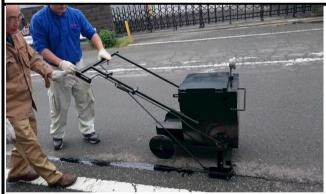
⑤注入工 193℃~232℃範囲でシール材を注入します。 (ハンドルを持ちながら、前に押します)
