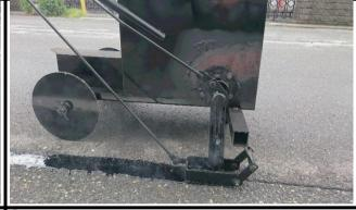
⑥注入工 シール注入量 m/約0.3kg 冷却時に体積収縮が見られるため、少し分厚目に注入し ます。(また凹みが生じた場合、2度塗りも可能です)
