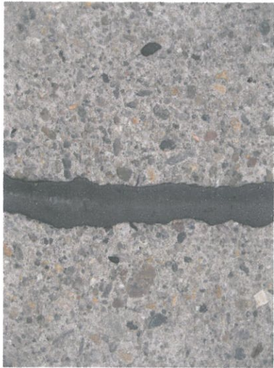
シール施工後
