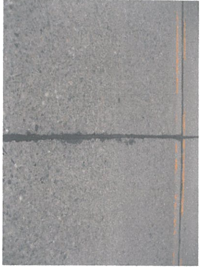
シール施工後
