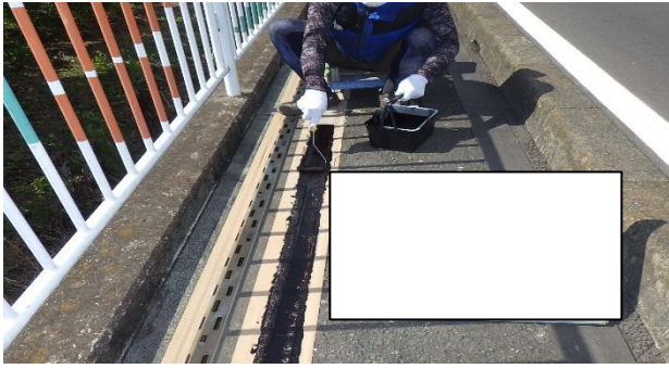
⑤MK プライマー塗布 MK もるもるの表面やコンクリート部に塗布する。塗布量 m/0.1Kg
