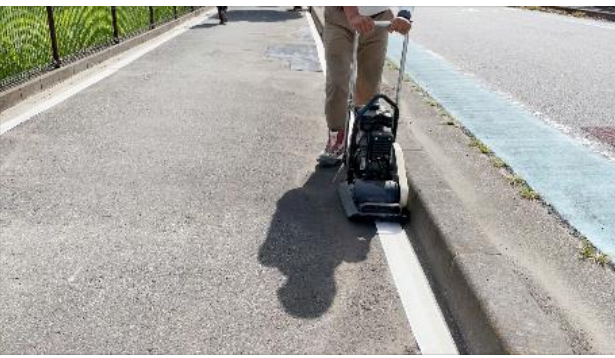
⑥クイックシール転圧 プレートをかけることにより、密着するので、推奨します。
