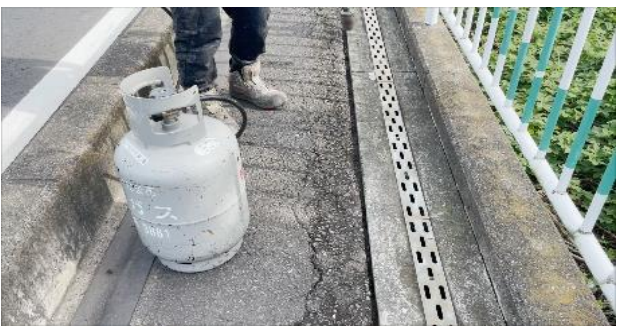
③清掃工 根が目地部から飛び出ている場合などは取り除き、難しいは根焼きをする
