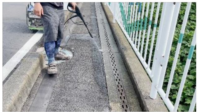
③清掃工 目地部を高圧洗浄で洗う
