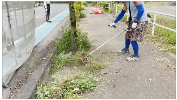
②準備工 除草作業除草したところを舗装切断する
