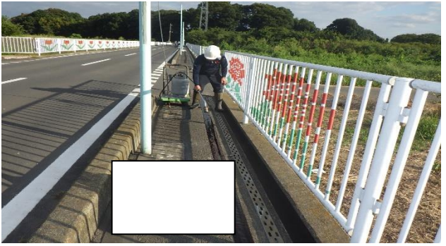
⑥クイックシール貼付け MK プライマーが指で触ってもらつかないことを確認後クイックシールを貼付け
