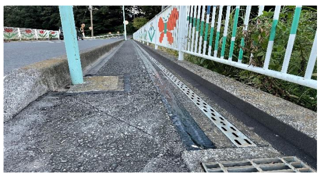
⑥クイックシール炙り クイックシールの白い離形紙を剥がしてからバーナーで炙る。炙り時間は3秒程度
