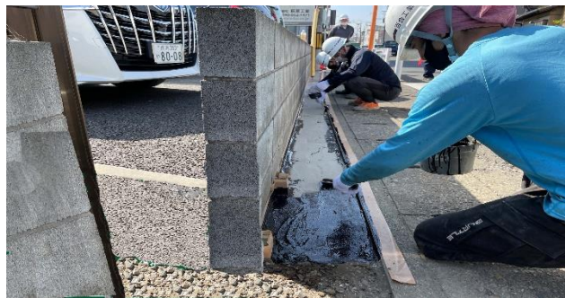
⑤プライマー塗布
