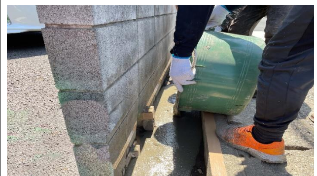
④防草カットモルタル充填
