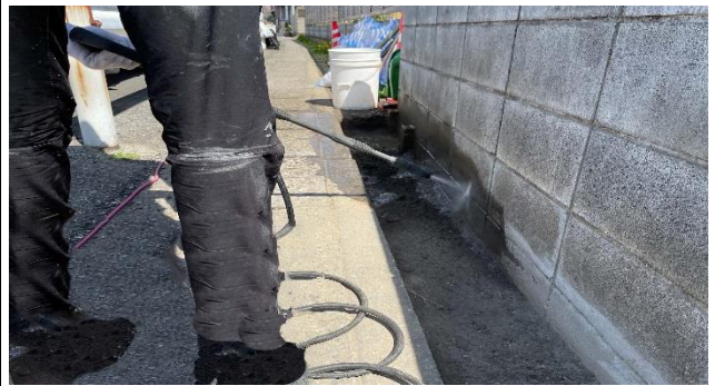
②除草作業除草したところに高圧洗浄機で清掃する。
