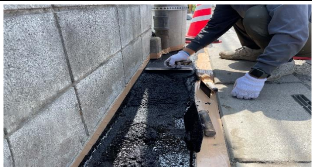
⑦クイックパッチ保護材敷き均し
