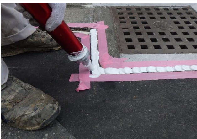
⑤シールを充填 ロードセイバーシリコンを充填しヘラで敷き均す
