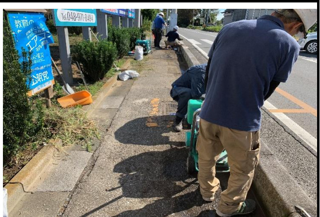
②除草作業除草したところを舗装切断する
