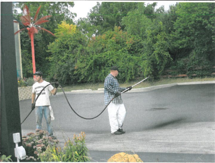
スプレーにより広く均一に塗布する
