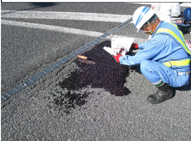
③ HPパーマネントパッチ(開粒型)を敷き均します。
