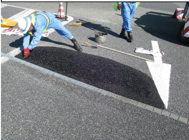
⑤ 端部をコテ仕上げます。
