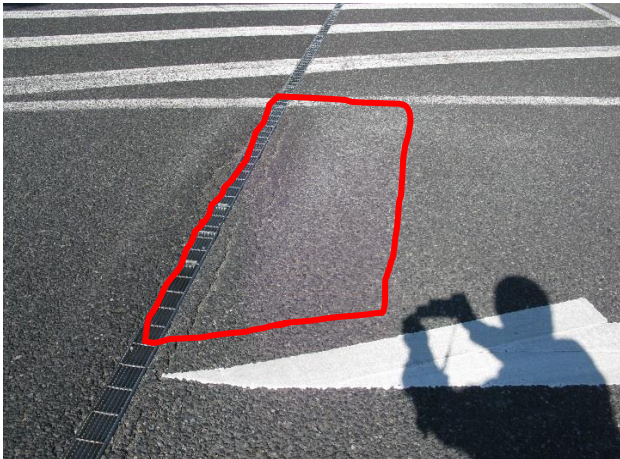
① 施工前(補修箇所確認)
