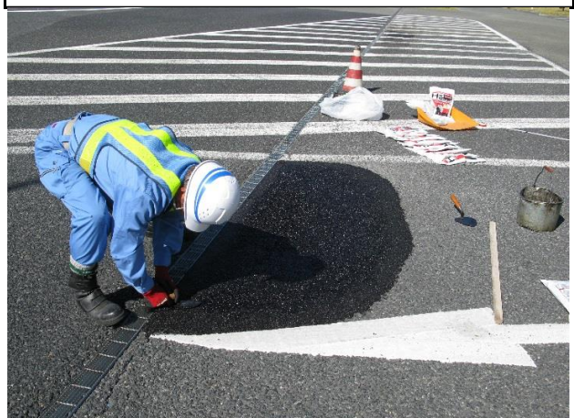
④ HPパーマネントパッチ(開粒型)を敷き均し、HPパーマネントパッチSA(細粒型)で端部を廻りを敷き均します。
