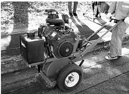
ひび割れのカット
