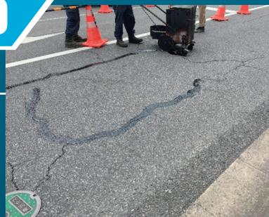
スーパーフレックスはアスファルト舗装及びコンクリート舗装のクラックシール材です。冬場の割れや、夏場の気温により溶け出すことなく高い接着性と柔軟性を持った製品です。直火型溶解釜で溶解できる素材です。
