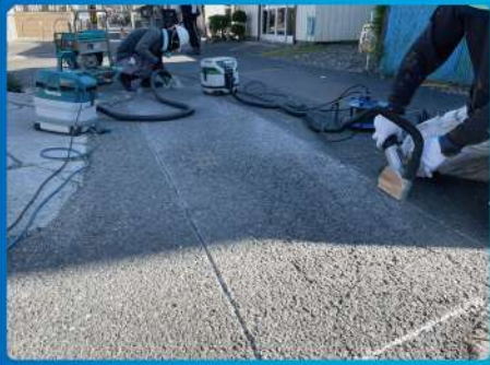
① 切削工 端部をUカットする
