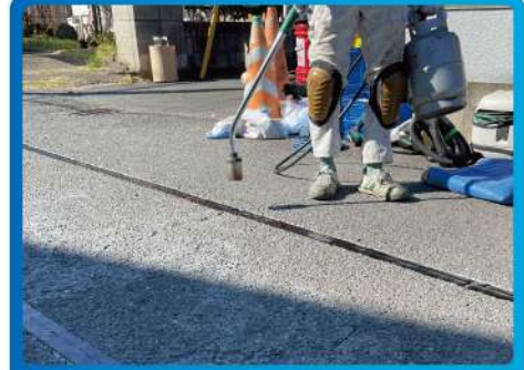
③ 端部処理工 クイックシールを端部に貼付け バーナーで炙る
