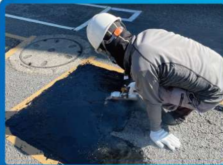
⑤ 敷均し工 マスチックワンを専用コテで 敷均しする
