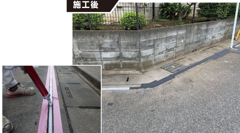
ロードセイバーシリコンシーラント注入
