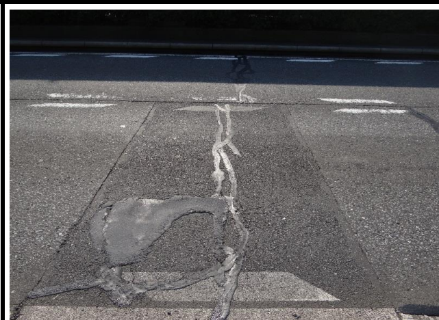
⑤ 完成後 コテで仕上げます。40℃以下になれば交通開放できます。
