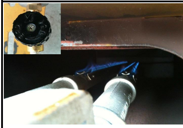
②-2 溶解釜の準備 直結バーナーの火力の調節は拡大写真の位置へひねると写真の炎の大きさとなります。(マークが本体側の方向へくる約180度)
