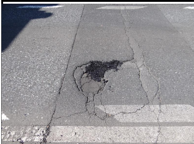
④ 材料投入 材料が190℃～210℃の状態です。端部から材料を投入します。
