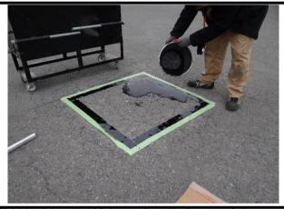
④材料溶解 焦がさないように混ぜることが重要で す。溶解後(190℃~210℃)でまた完全に骨材とバイ ンダーが混ぜ合わさったことを確認後、端部から塗布 します。(クイックシールは101℃が軟化点です)
