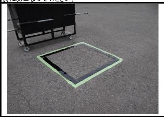
③施工面の縁の接着性が気になる場合、周りにクッ クシールを貼るかもしくは推奨するアスファルトプライ マーを塗布してください。
