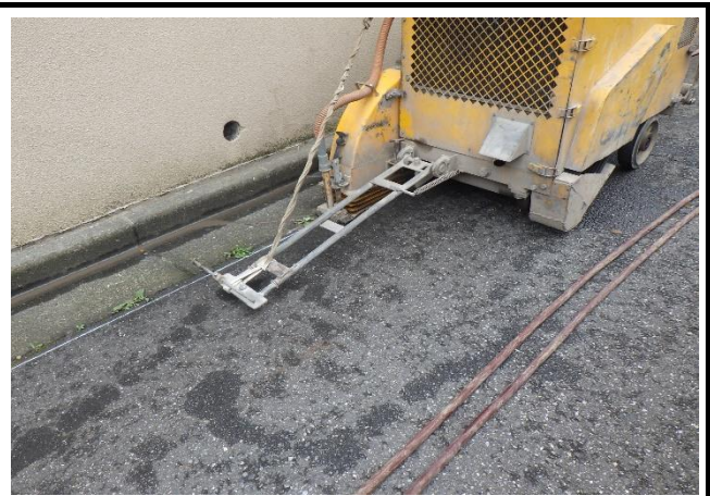
②除草作業除草したところを舗装切断する
