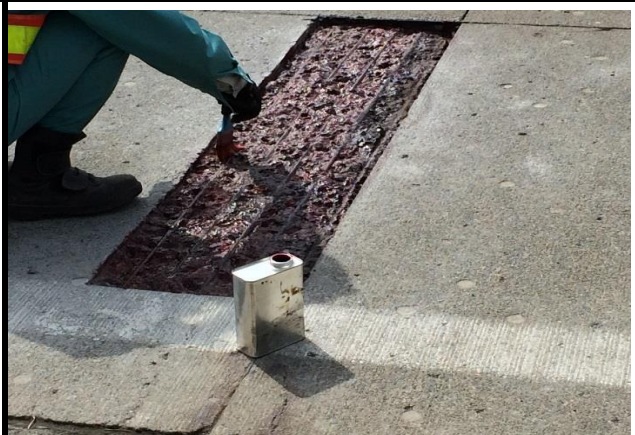
⑤プライマー塗布
