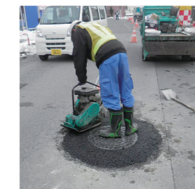
マンホール廻り補修
