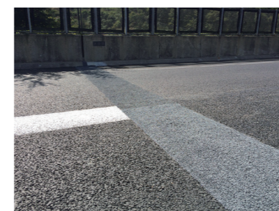
秋田自動車道 大曲IC橋(上り線)
