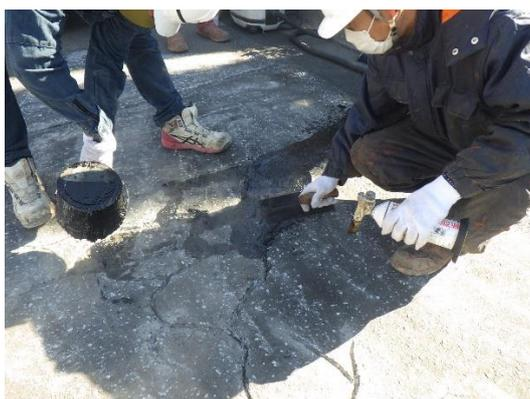
クラックの損傷部や段差がある箇所にもスチックワン（クラックシール）を充填する。
