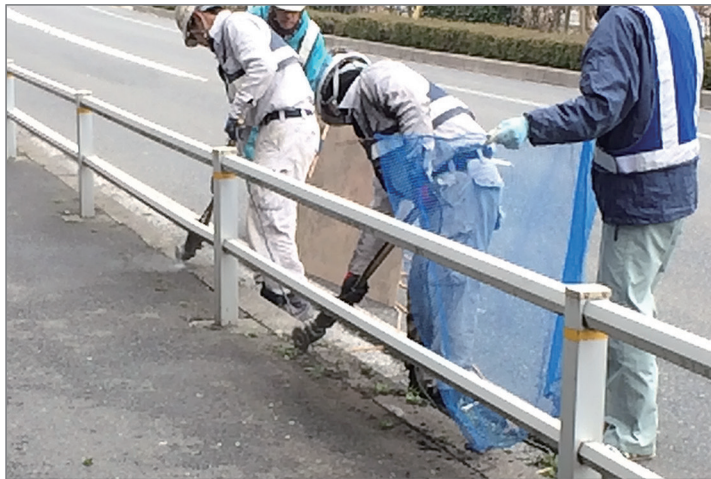
2 除草作業 除草した箇所を再度カッターを使い、切削する。
