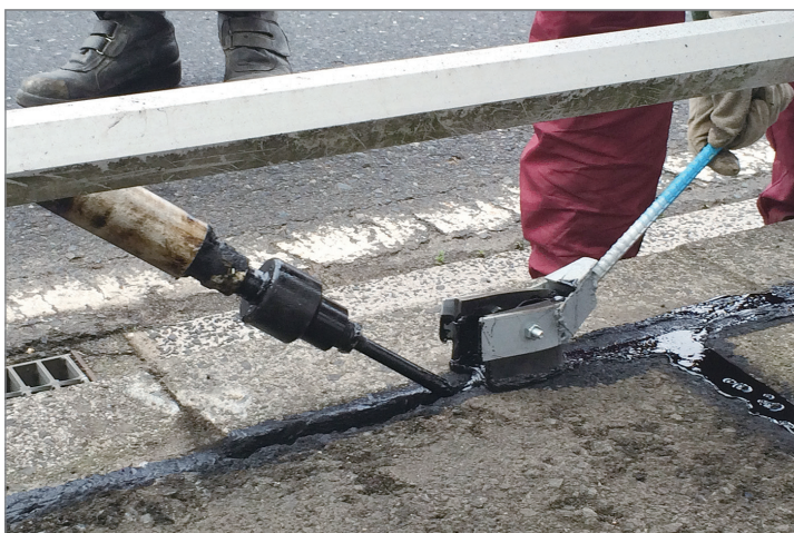
5 シールを充填 193℃～204℃に溶解したシール材を充填し、コテで均す。
