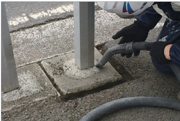
3 清掃作業 パーナーなどで乾燥後、ブラシで箇所を磨き、掃除機で砂などを吸い取る。
