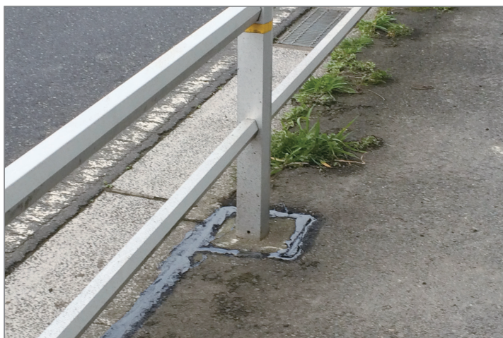
6 仕上がり比較 除草シールした箇所としていない箇所
