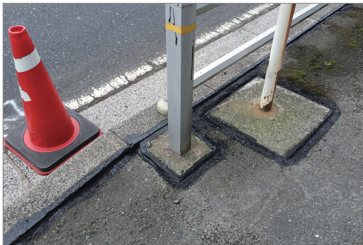
4 プライマー塗布作業 プライマーを塗布する。 (塗布量0.36% (0.33kg)/㎡)
