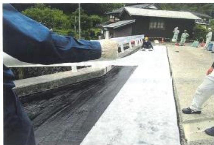
ウルトラシールを塗布した後、強化保護シートを張り付けるようす(=5日、智頭町宇波・夏明橋)
